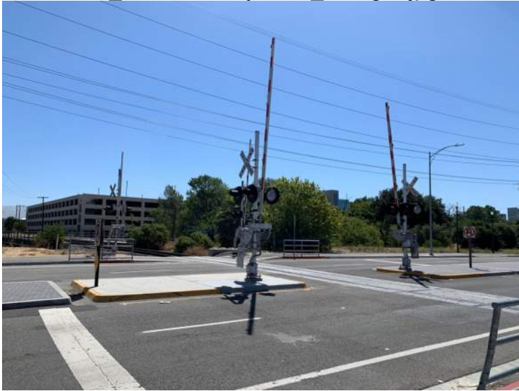
05_Autumn Pkwy Gate_facing E.jpg
