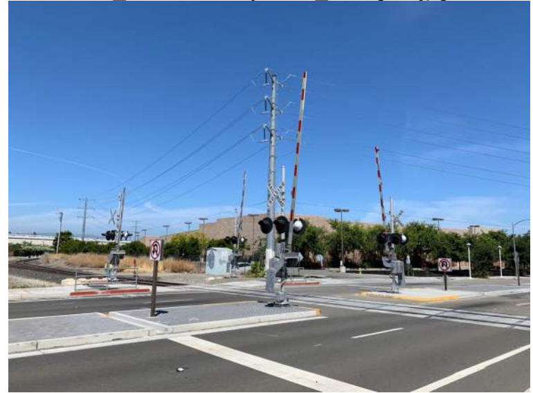
06_Autumn Pkwy Gate_facing W.jpg
