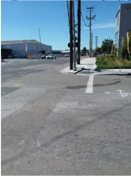
41_N 10 St Gate_facing N.jpg
