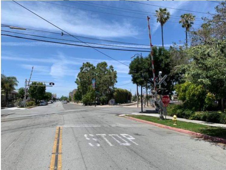
25_N 6 St Gate_facing N.jpg
