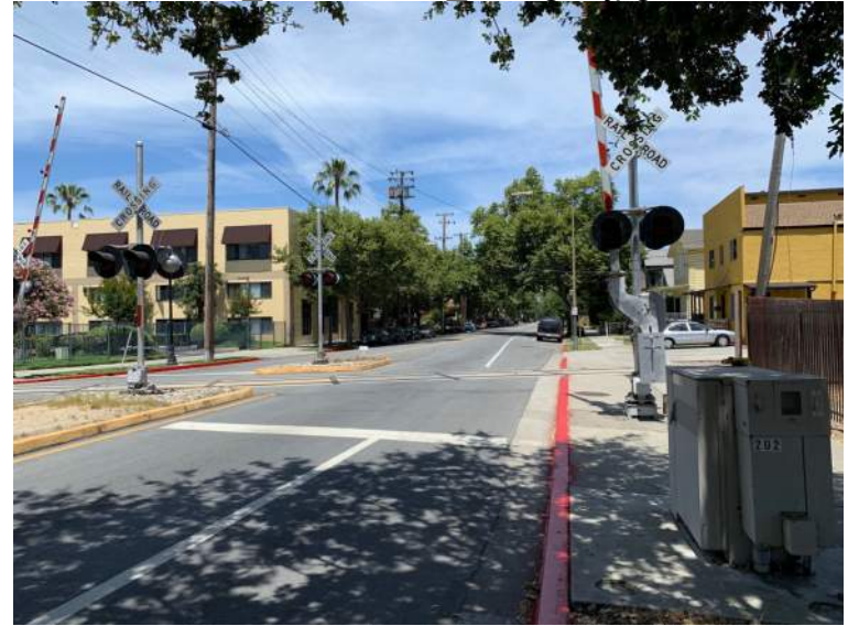
18_N 3 St Gate_facing N.jpg
