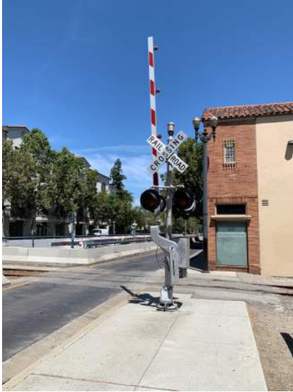
09_N 1 St Northbound Gate_facing N.jpg
