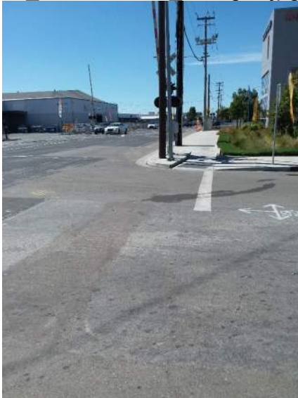
41_N 10 St Gate_facing N.jpg
