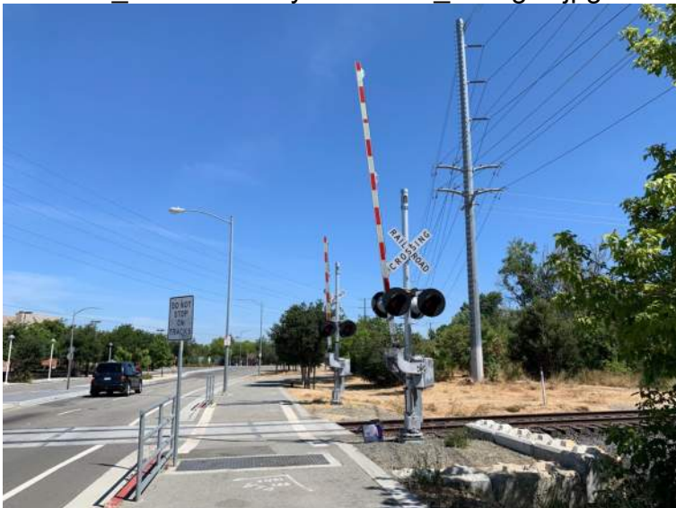
07_Autumn Pkwy Ped Gate_facing N.jpg
