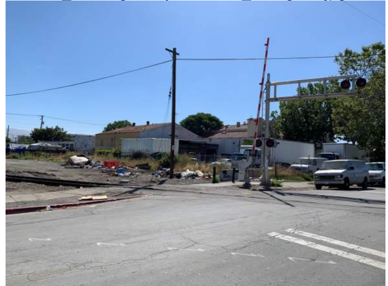
02_N Montgomery Sidewalk_facing SE.jpg
