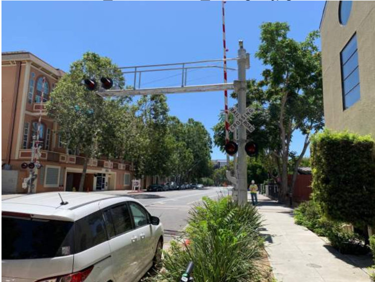
13_N 2 St Gate _facing S.jpg
