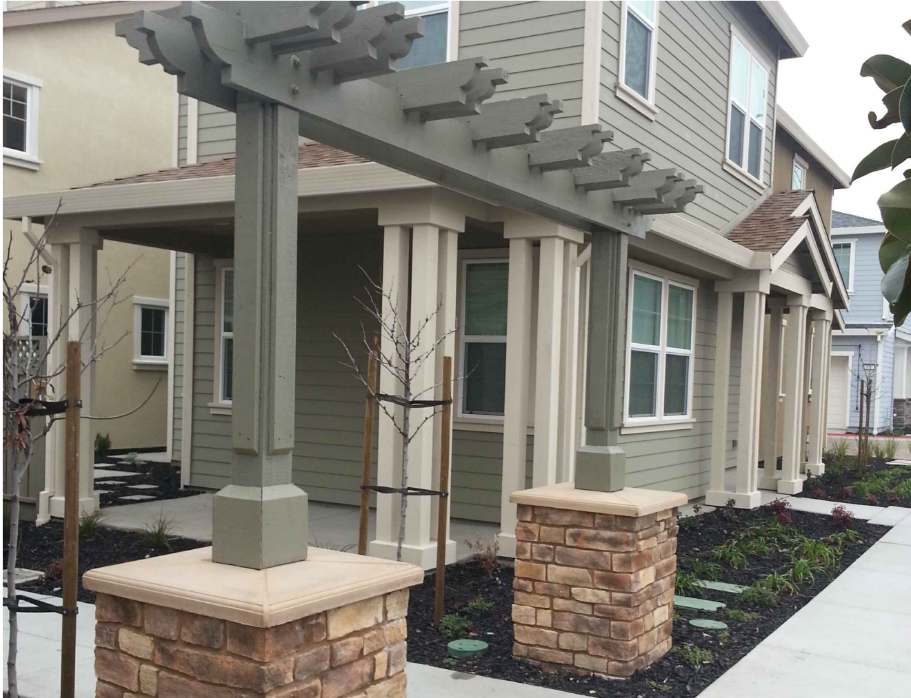
PASEO ENTRYWAY TRELLIS
