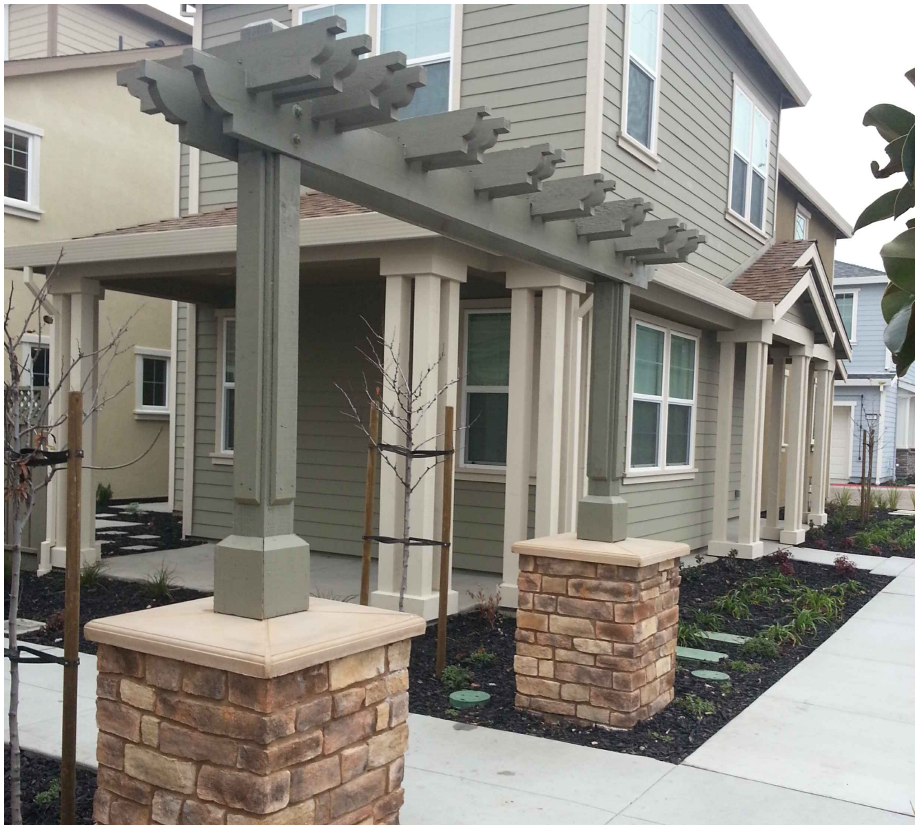
PASEO ENTRYWAY TRELLIS
